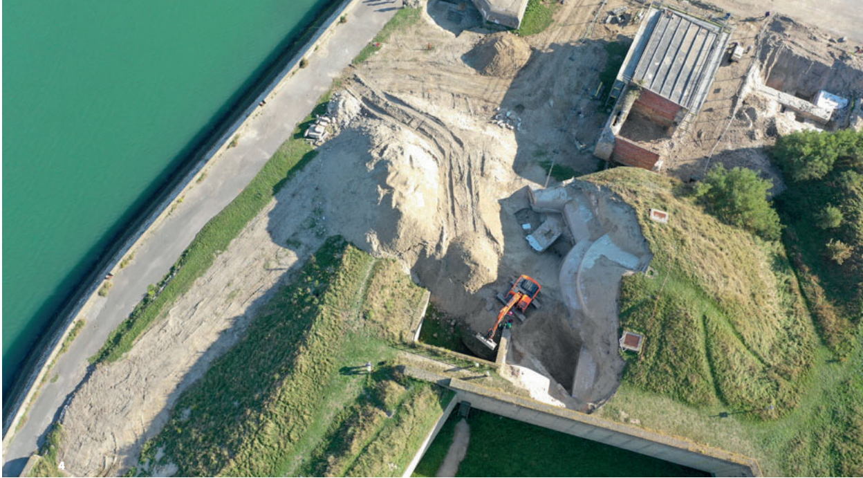
1. 2. 3. 4. 5.6 Différentes vues de la restauration du fort Risban
